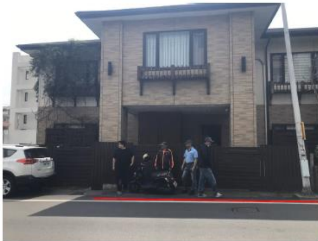
東側(禁止臨時停車線延伸至建物梁柱)
