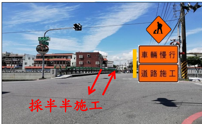
長安街與福建街 東昌橋北側
